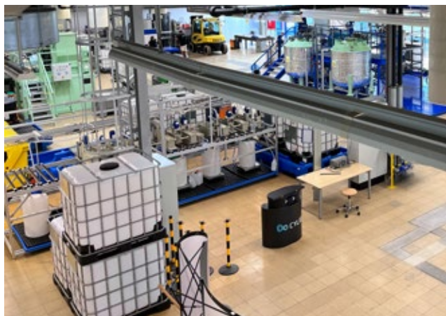
Abbildung 4: cylib Pilotfabrik in Aachen Rothe-Erde
